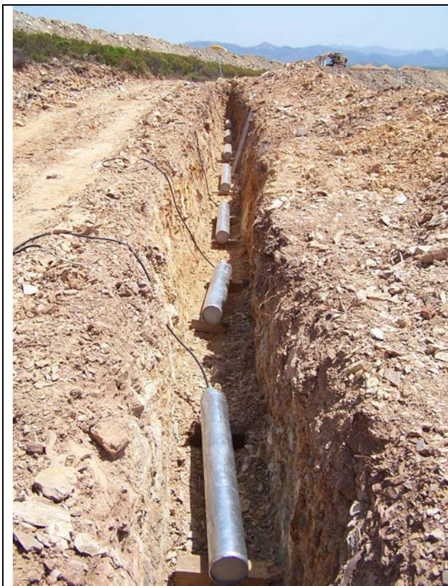
[fig.6] – Vista dello scavo e degli anodi pre-impaccati
