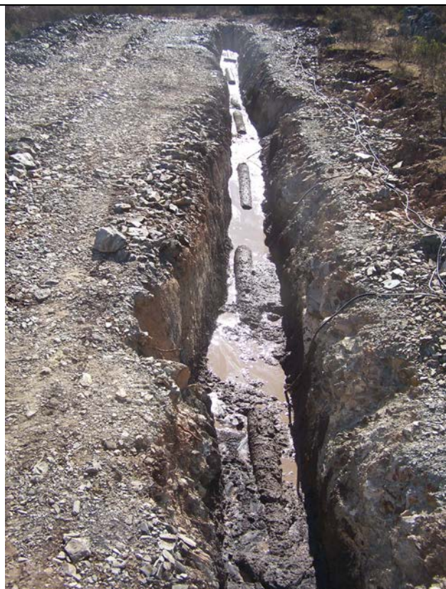
[fig.7] – La fase di rinterro degli anodi del dispersore
