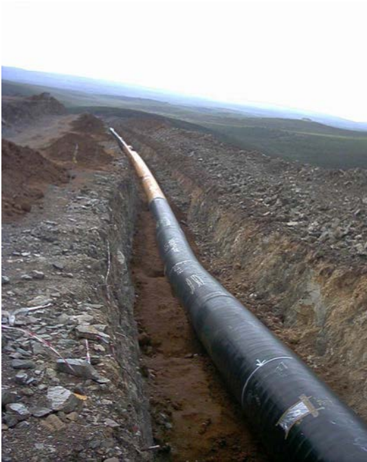
[fig.1] posa condotta B1
