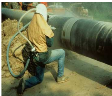
[fig.1] – Fase di applicazione del rivestimento per giunti di saldatura
