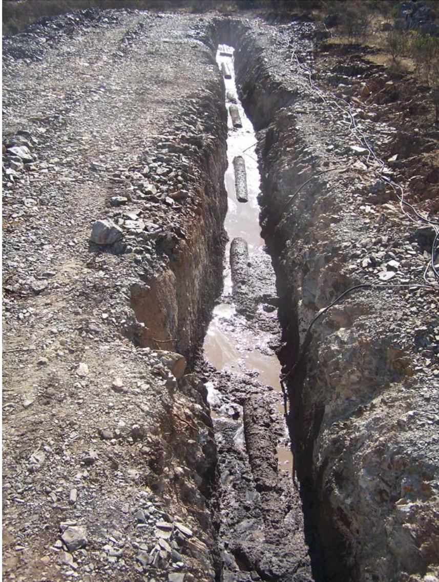
La realizzazione della connessione del cavo all'anodo ed il suo isolamento verso l'ambiente rappresentano le operazioni più delicate nell'assemblaggio e nella posa dei dispersori.
