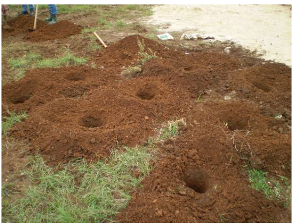
Esecuzione dei fori nel terreno
